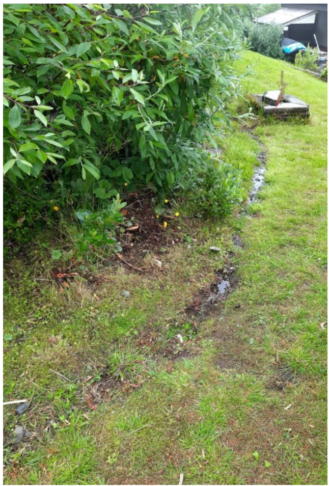
Mynd 5: Vatn sést greinilega efst í skurðinum. Hann er því væntanlega ekki að virka sem skyldi.
