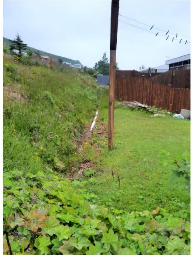
Mynd 3: Horft eftir lóðamörkunum á Fossvegi 13 í átt að Fossvegi 15. Drenlagn í yfirborði.
