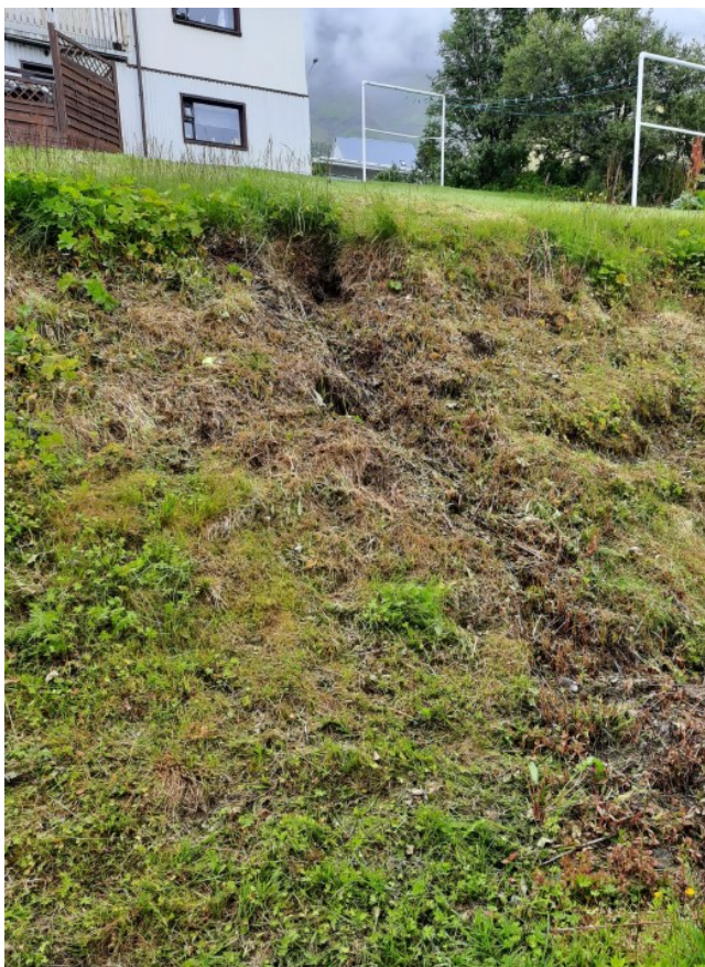
Mynd 6: Hér sést fláinn á milli lóðanna og rásin sem vatnið virðist koma úr.
