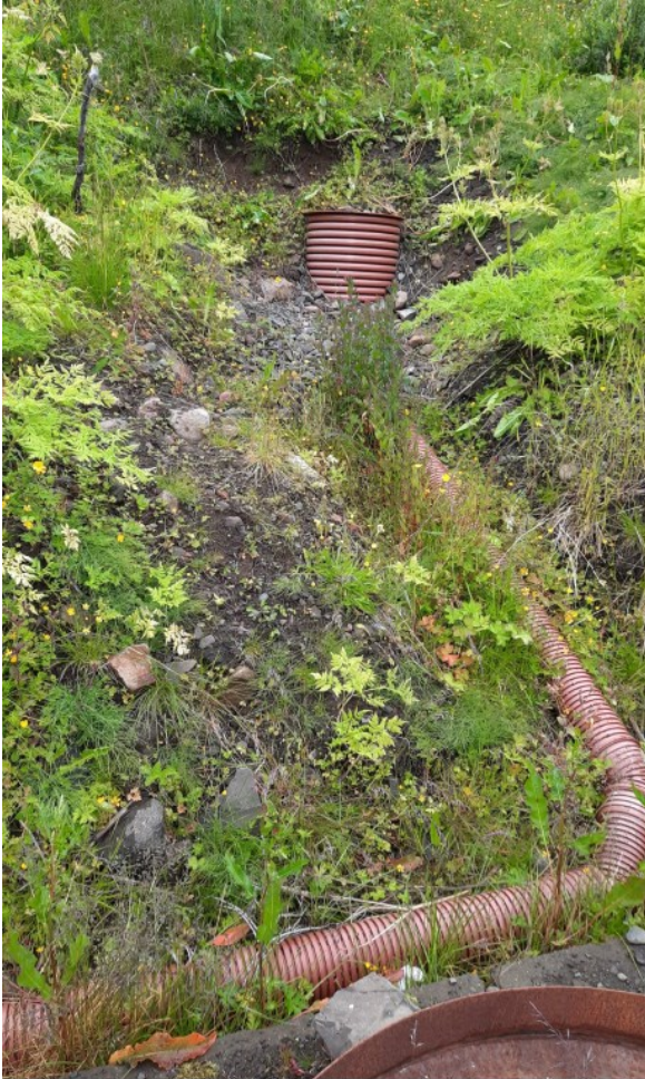
Mynd 8: Uppi í fláanum hefur verið settur safnbrunnur og vatn leitt frá honum að bæjarkerfinu.
