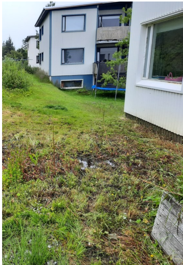
Mynd 7: Hér sést svæðið ofan húss neðan við fláann. Sjá má all nokkra bleytu.
