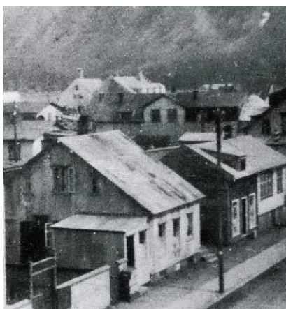
Húsið í byrjun 20 aldar - ein hæð með risþaki
