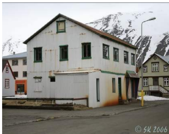
Aðalgata 22 stuttu áður en það er rífið
