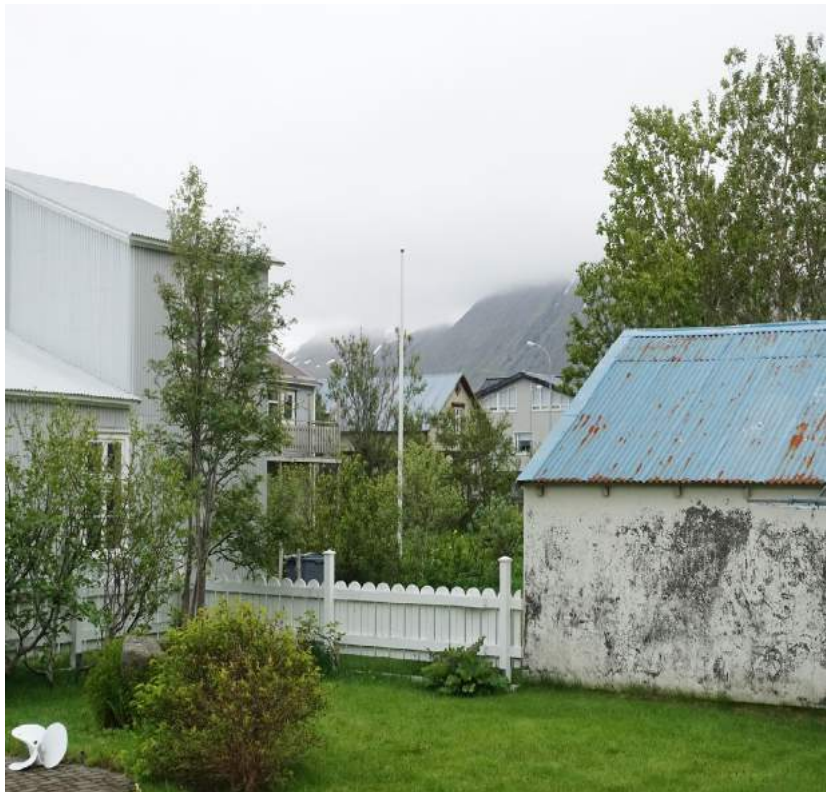
Baklóð Grundargötu 12. Herhúsið t.v. og bílskúr Grundargötu 10 t.h.
